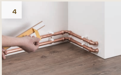
4 Montageprofil mit Hilfe des vorkonfektionierten Klebebandes am Boden befestigen
