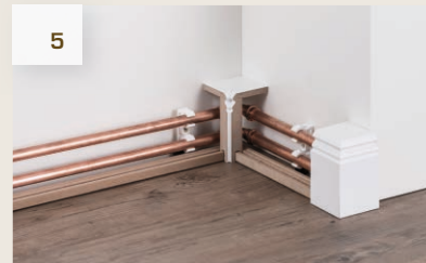
5 Vorgefertigte Innen- / Außenecken aufstecken
